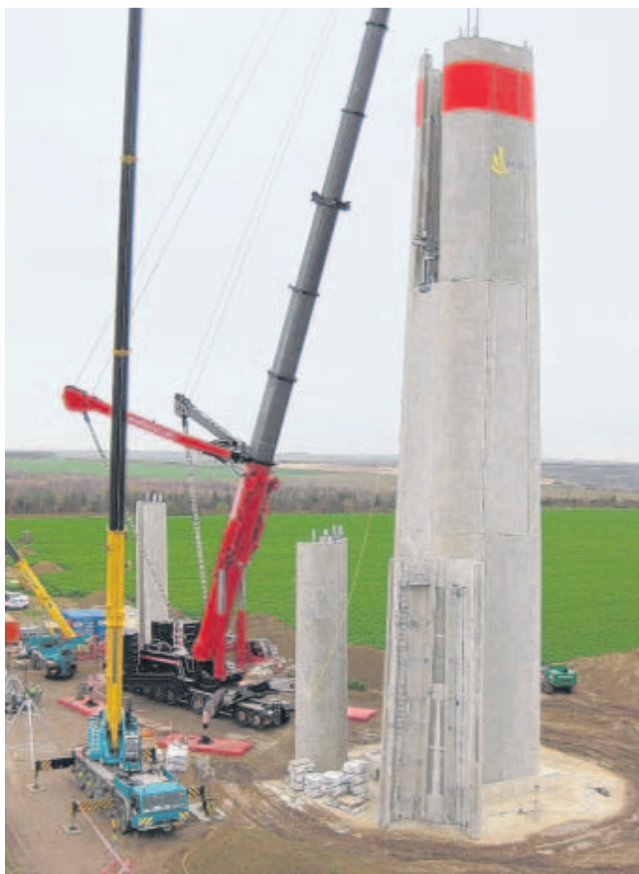
In Grevenbroich bei Düsseldorf werden dieser Tage die Arbeiten an Deutschlands höchstem Hybridwindturm beendet. Die 133 Meter hohe Anlage besteht aus einem Betonsockel und einer Konstruktion aus Stahlrohren, die darauf aufgesetzt. Die Betreiber erhoffen sich von der großen Höhe einen im Vergleich zu herkömmlichen Türmen um bis zu ein Fünftel höheren Stromertrag.
