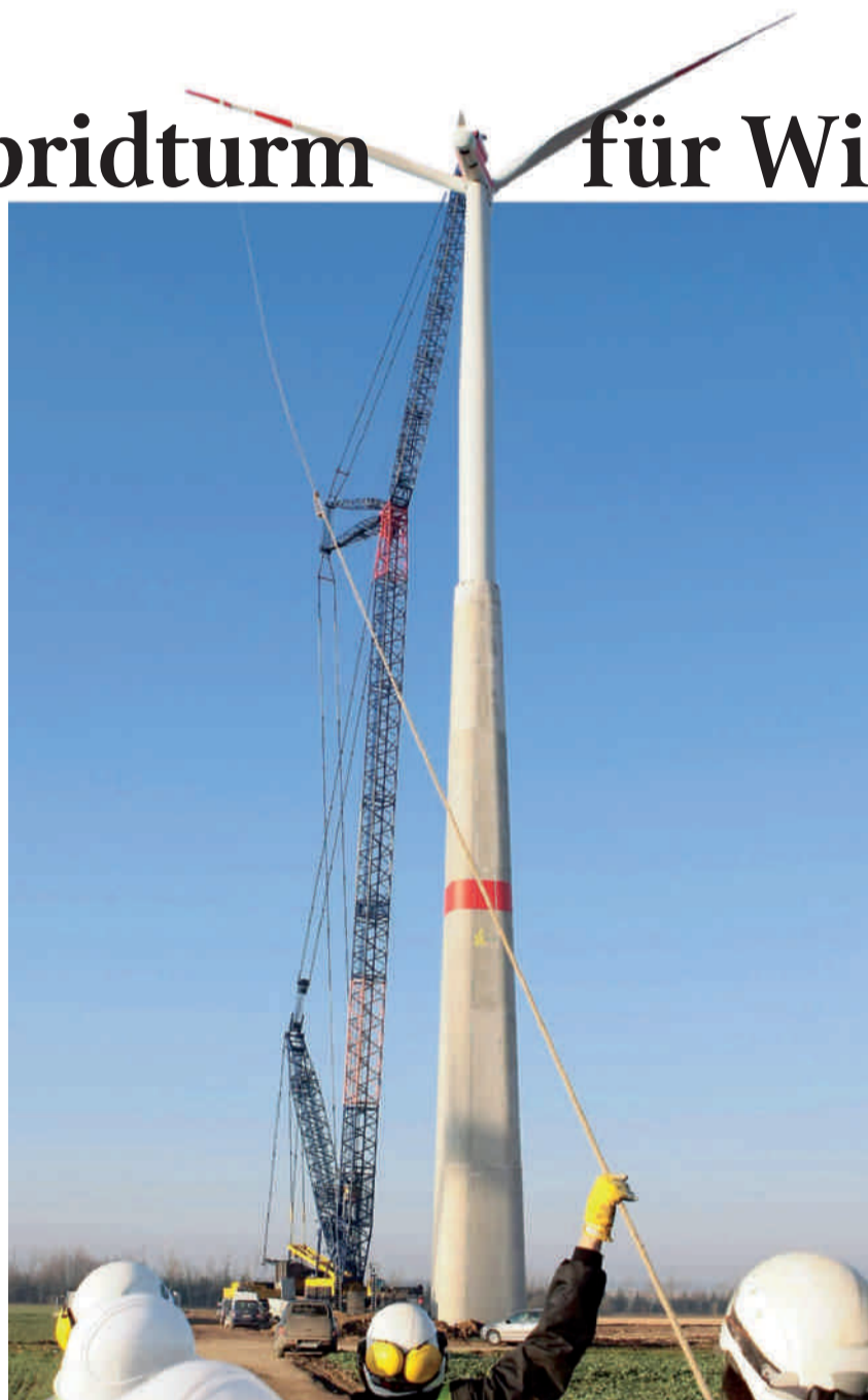
Neue Turmbauweise: Unten werden hohe, schmale Betonfertigteile verwendet, oben konventionelle Stahlelemente.
