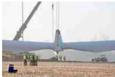
45 Tonnen wiegt der dreiflügelige Propeller, der einzeln angeliefert und auf dem Feld zusammengebaut wurde. (Fotos (3): Uli Engers)
